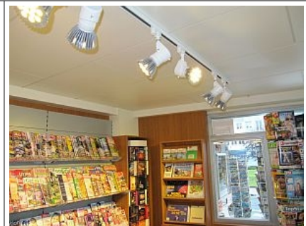
Trafikbeleuchtung im 3-Phasenstromschienensystem
